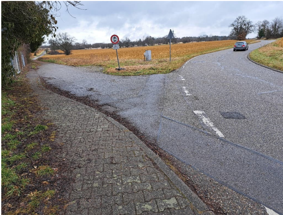
Bild 3: Zufahrt Feldweg „Dachgrube“ (links im Bild), Weiterer Verlauf Nußbaumstraße Blickrichtung vom Baugebiet in Nord-Östliche Richtung
