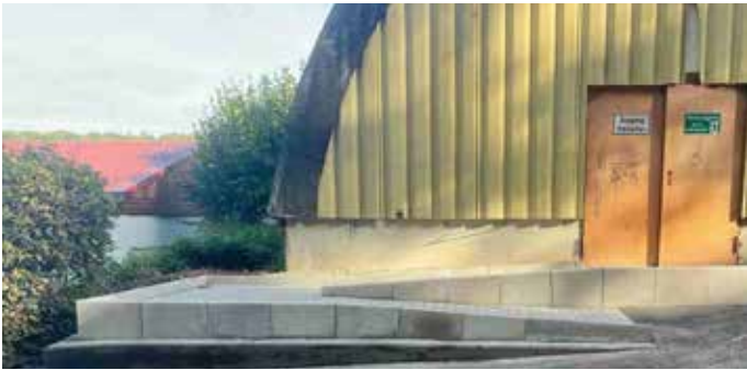
Ausfahrt an der Ringer-Halle
