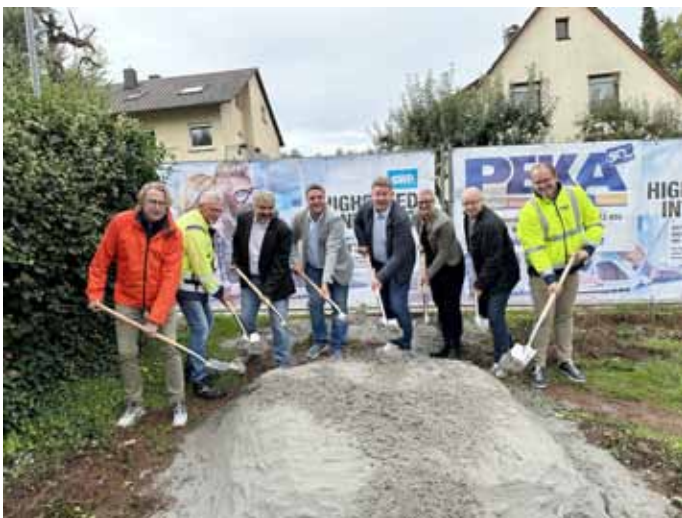
Mit dem Spatenstich von Andreas Kienzler, Uwe Schröder, Wolfgang Rößler, Kristian Kronenwetter, Thomas Zeilmeier, Sandra Koller, Thomas Ruppender und Dominik Schuster (von links) wird der offizielle Start des Glasfaserausbaus in Ispringen eingeleitet. Foto: Mühlthaler
