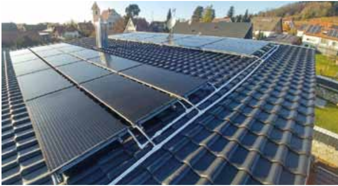
Ein Hybridmodul (PVT-Modul) vereint Photovoltaik-Technik mit Solarthermie (unterhalb der PV-Module angebracht).
