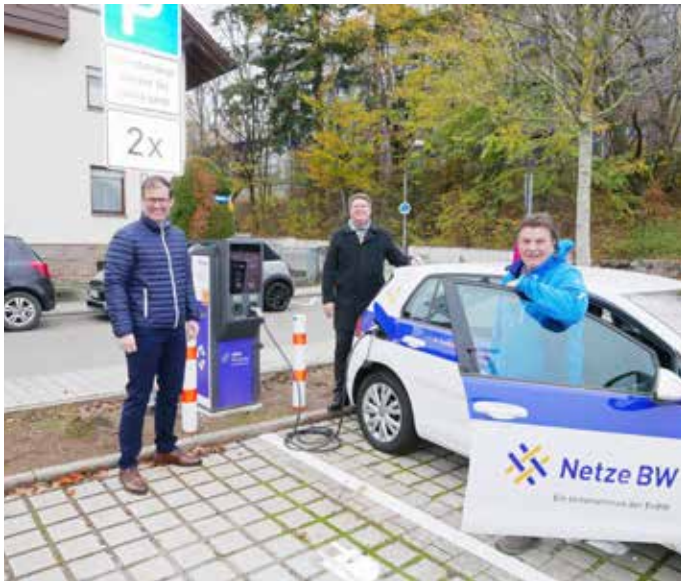
Anschlussfertig ist die E-Ladestation auf dem Parkplatz der Sport- und Festhalle, die von Tino Stutz im Beisein von Bürgermeister Thomas Zeilmeier und Joachim Vogt der Öffentlichkeit übergeben wurde (von links).
